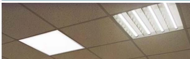
Светодиодные панели ULP-6060 типоразмера 600×600 мм могут устанавливаться в подвесные потолки типа «Армстронг» и являются прямой заменой растровых светильников с люминесцентными лампами (ЛВО 4×18 Вт, стандартный модуль размером 600×600 мм).
